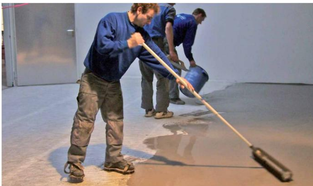
Робота з нівелюючою масою UZIN NC 170 LevelStar вільно лежачий підкладці UZIN RR 201
